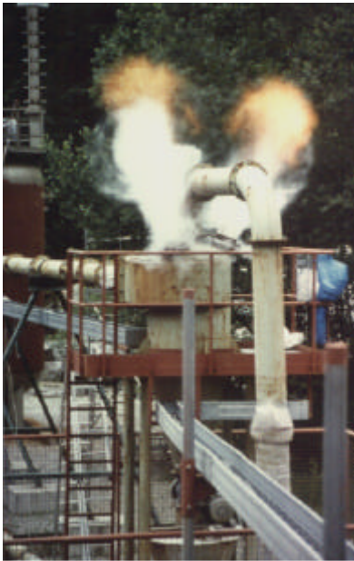
Abbildung 2: Explosionsübertragung durch die Rohrleitung einer pneumatischen Entstaubungsanlage von einem 10 m 3 -Behälter in ein druckentlastetes Zyklon.
