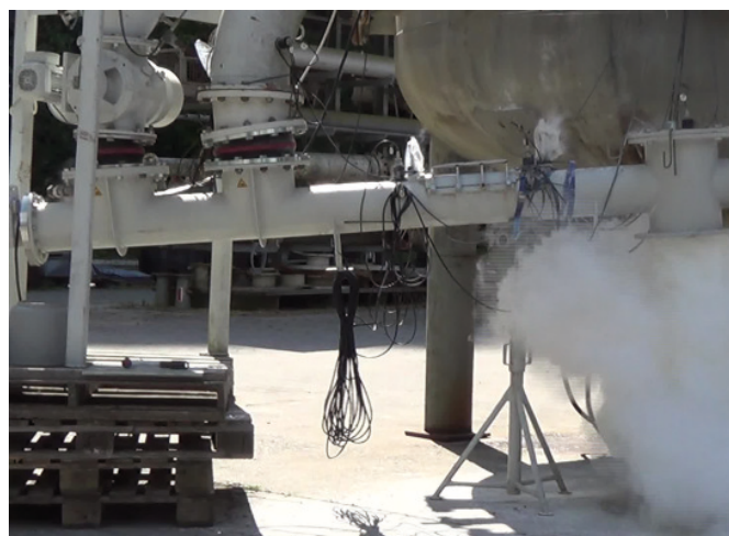
Bild 5 Explosionsversuch mit Cellulose. Es ist lediglich starker Staubaustritt zu beobachten. Die Flammenübertragung aus dem Explosionsbehälter durch die Rohrförderschnecke hindurch wird durch den Schüttgutpfropfen in der Rohrförderschnecke verhindert.
