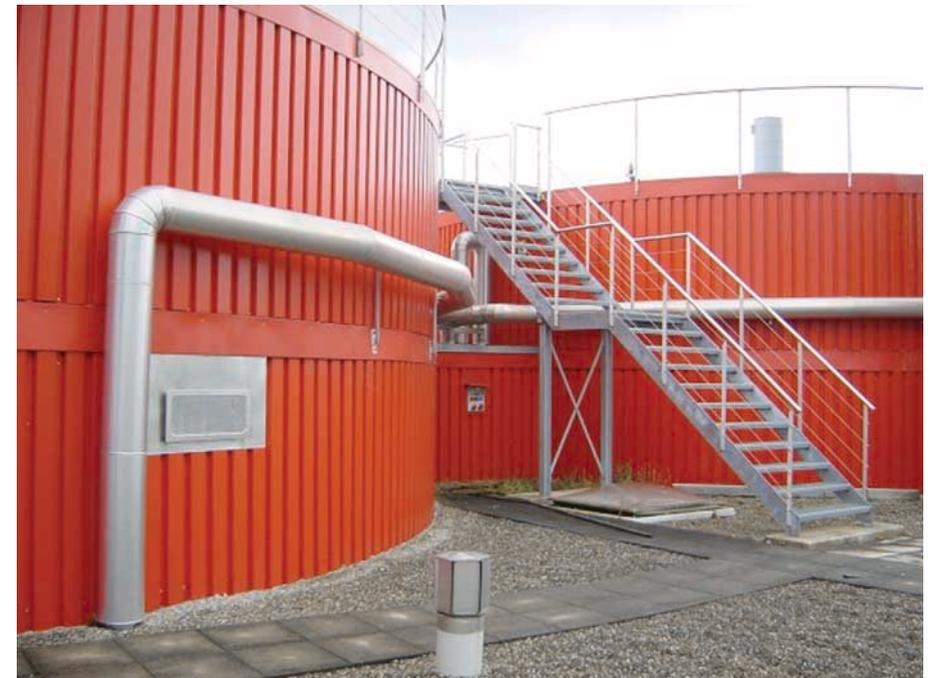
Bild 16: Zwei Faultürme mit integrierten Gasometern<sup>1)</sup>
