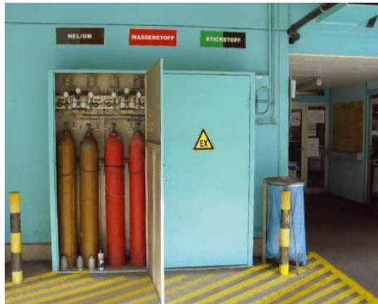
Aufgrund des regelmäßigen Austausches der Druckgasflaschen ist gelegentlich mit dem Auftreten einer explosionsfähigen Atmosphäre zu rechnen. Daher wurde innerhalb des Schrankes Zone 1 festgelegt. Oberhalb des Schrankes wird 1 m als Zone 2 festgelegt.
