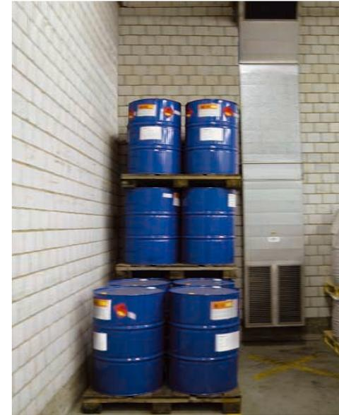
Aufgrund der hier vorhandenen technischen Lüftung ist der Lagerbereich zonenfrei. Ohne diese technische Lüftung wäre eine Zone 2 festzulegen.
