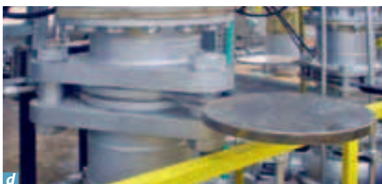
Bild 30 Beispiele von Instandhaltungsmassnahmen: a) Schweißerlaubnisschein; b) Gaswarngerät zum Personenschutz; c) Messen der möglichen explosionsfähigen Atmosphäre; d) Steckscheibe; e) Kontrolle der Schutzmassnahmen in den Zonen
