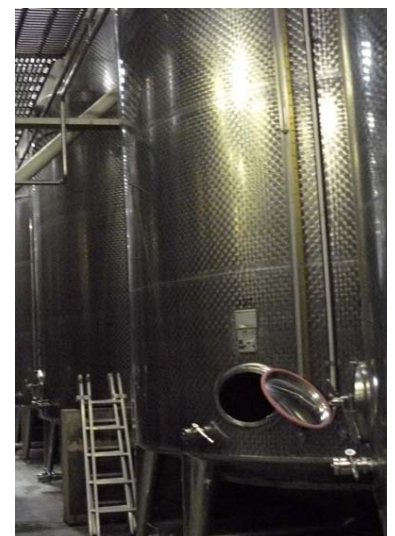
Abb. 10: Entlüftung über Mannloch
