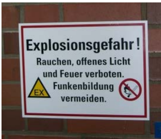
Abb. 12: Beispiel einer Kennzeichnung neben dem Zugang zu einem explosionsgefährdeten Bereich
