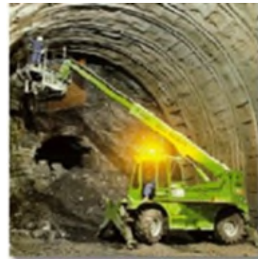
Arbeitsplattform, die mit einem Teleskopstapler zusammengebaut ist
